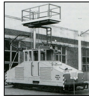
Elektrolokomotive 239 II in Ursprungsausführung und als Turmtriebwagen (ab 1967)
