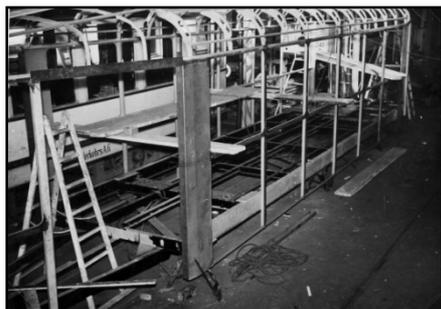
links Bw 104 III, Wagenkastengerippe aus Holz, Umbau 1958, Hauptwerkstatt Bleichpfad
